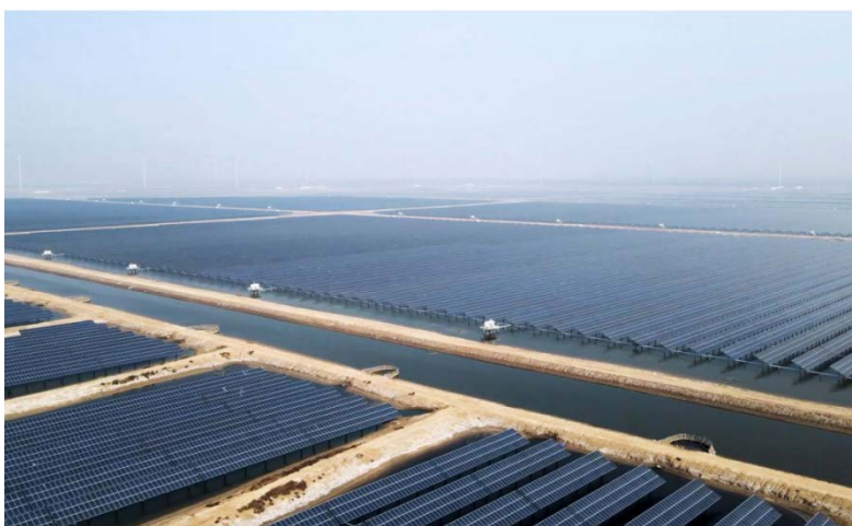
中国山东滨州沾化“渔光一体”项目
